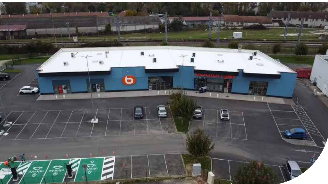
Toiture avec peinture blanche réfléchissante et 5 bornes IRVE (Provins, 77)
