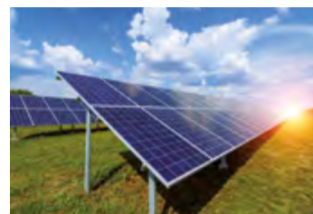
Centrale au sol
