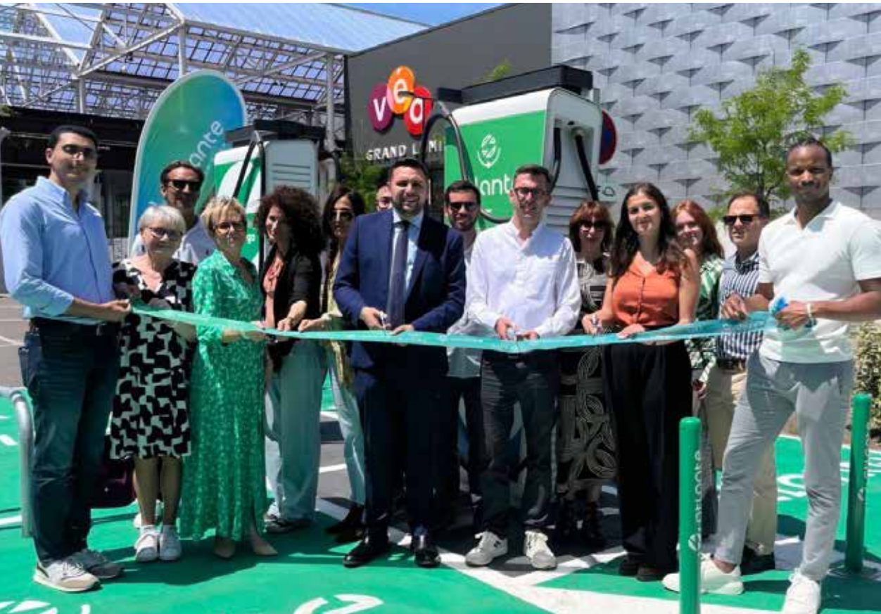
Inauguration d'une station de recharge électrique au centre commercial de Saint-Chamond (42)
