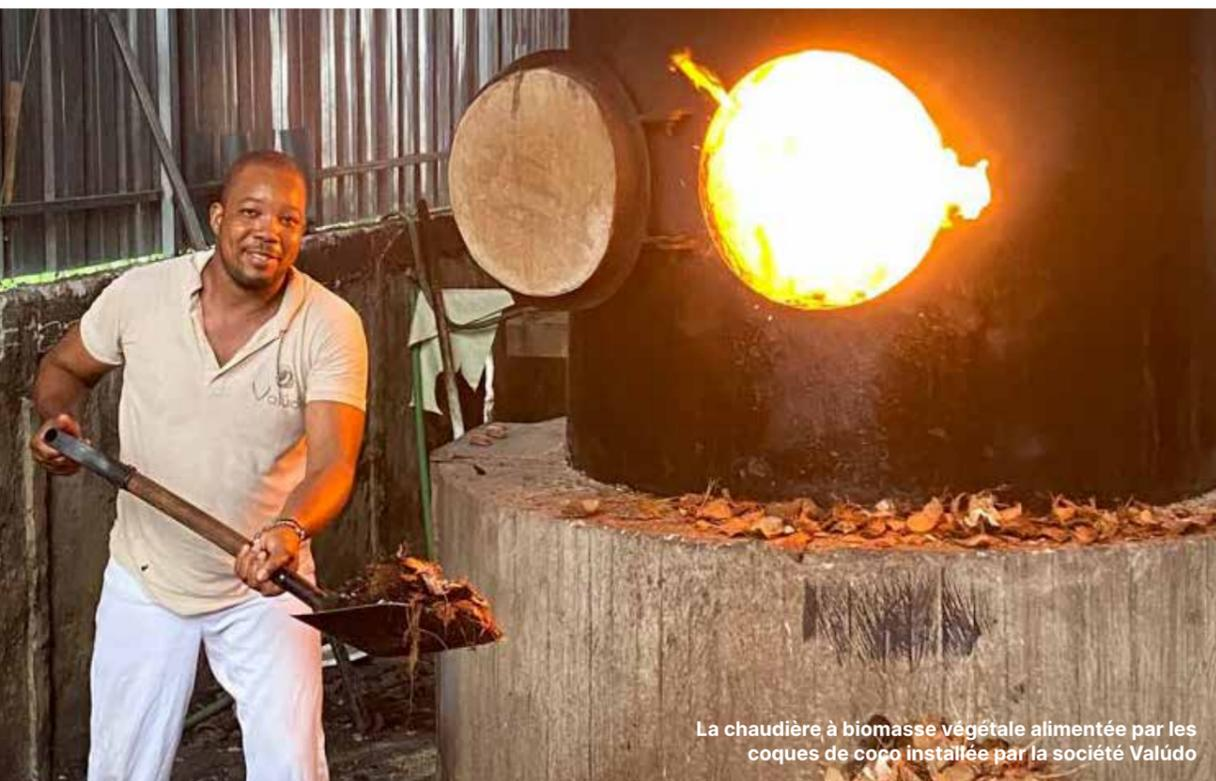
La chaudière à biomasse végétale alimentée par les coques de coco installée par la société Valúdo
